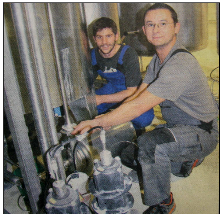
Jannis Werner (l.) und der technische Betriebsleiter Andreas Frack kontrollieren die Ventile am Siruplager. Die Ventile werden ebenfalls automatisch gesteuert.
